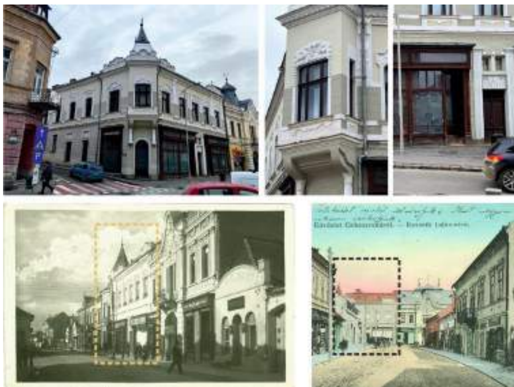
Figura 128 - Clădire – Strada Petofi Sandor nr. 1
