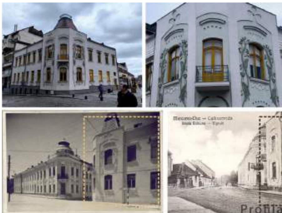
Figura 126 - Clădire – Strada Petofi Sandor nr. 36
