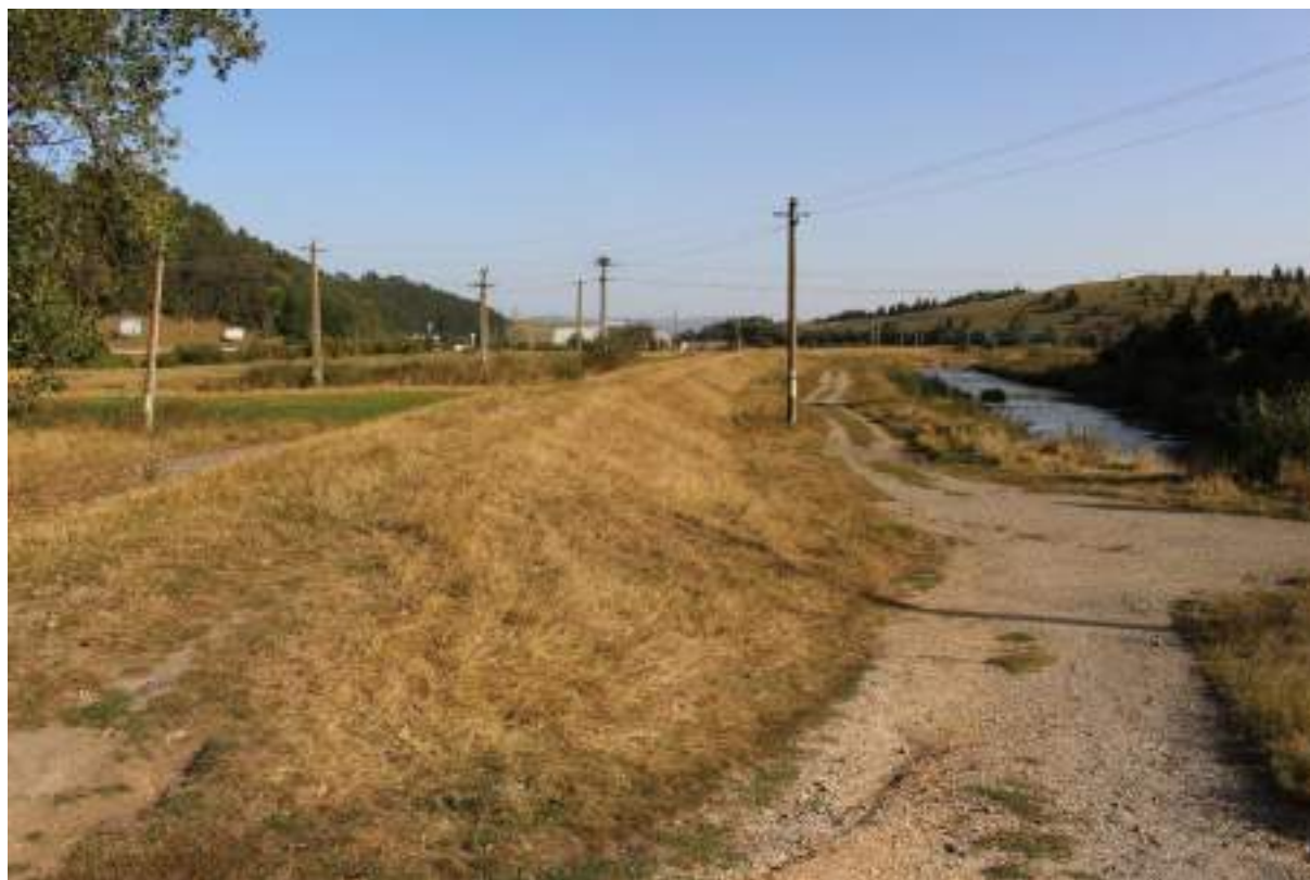
Figura 83 – Dig de protecție la viituri pe râul Olt
